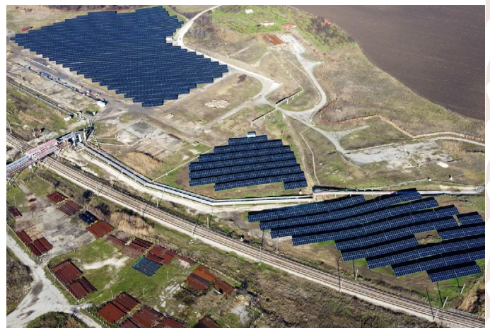
©GreenYellow. Centrale solaire Solway en Bulgarie de 4 MW de puissance pour une production annuelle de 5,3 GWh d'énergie verte.
